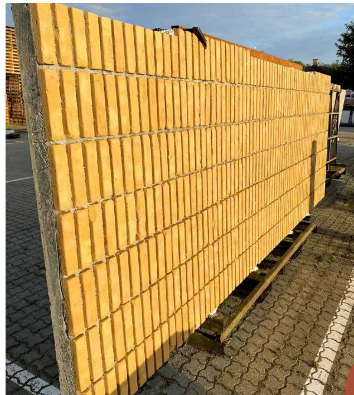
Eksempel på præfabrikeret specialelement i tegl og beton.
